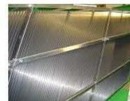
La cellule lamellaire est constituée de plaques en aluminium espacées de 30mm. Les plaques sont inclinées à 60° par rapport à l'horizontale ce qui permet le glissement des boues vers la zone de stockage. Le volume de stockage est dimensionné pour une vidange tous les 3 mois (variable selon la nature de l'effluent).
